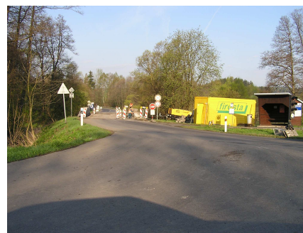
Rekonstrukce mostu přes Moravici
