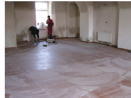
Budoucí schůzovní místnost ve výstavbě
